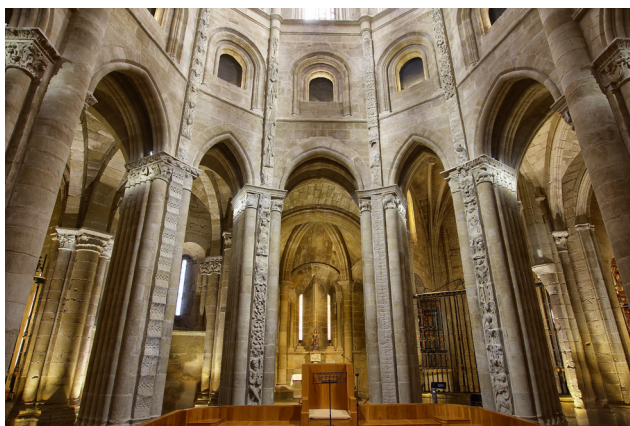
Lám. 13. Vista general de la cabecera de la catedral de Santo Domingo de la Calzada . Foto Elena Aranda y Roberto Chaverri.
