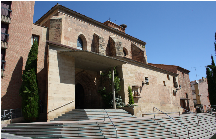
Fig. 8. Patio y pórtico de la iglesia de Santo Tomás Apóstol.
