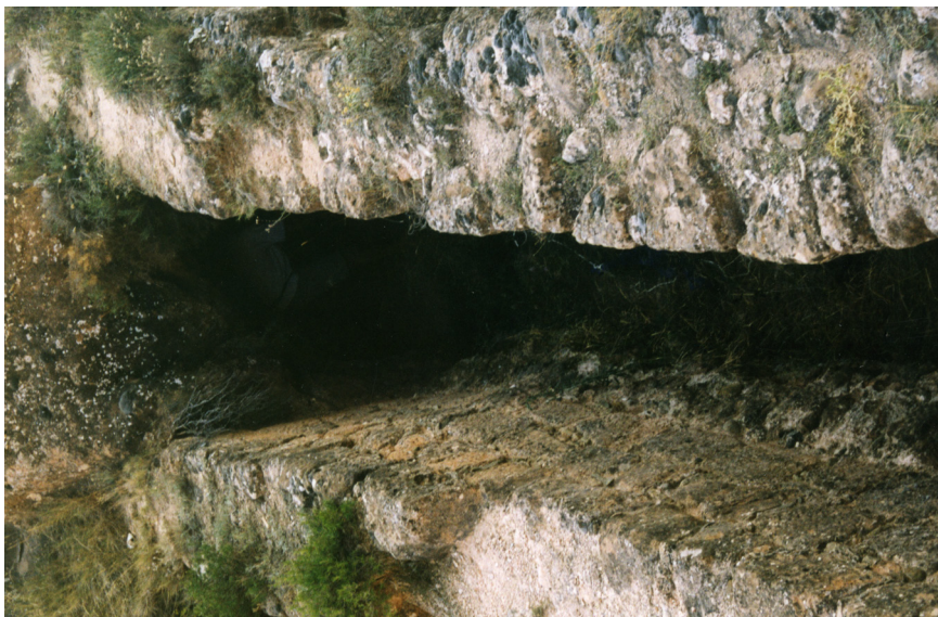
Fot. 11: Potencia de los muros de uno de los primeros puentes de la poterna que sale Desde Arnedo hacia La Maja.
