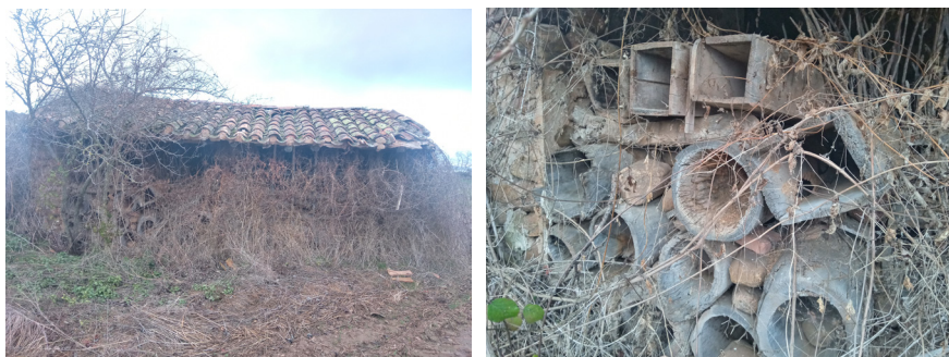
Lám. 5 y Lám. 6. Colmenar del Tío Modesto, o de Los Linares (fotos panorámica y de detalle de sus vasos).
