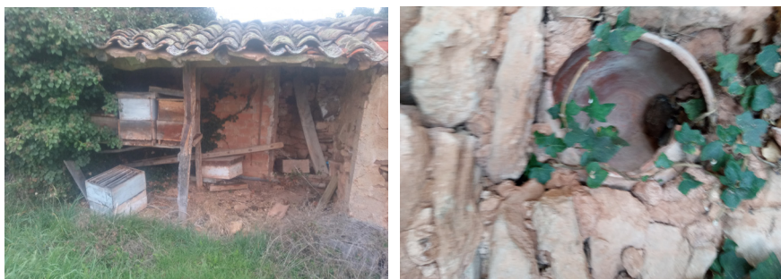
Lám. 7. Colmenar de Ruyarena. Detalle constructivo que incluye tinajas de barro.
