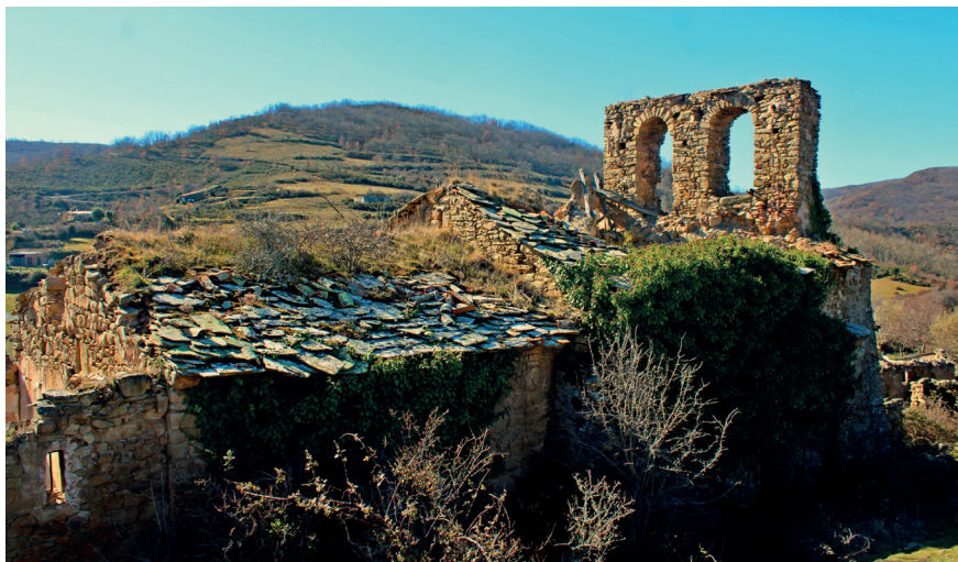
Lám. 13. Iglesia de San Juan Bautista. El Collado.
