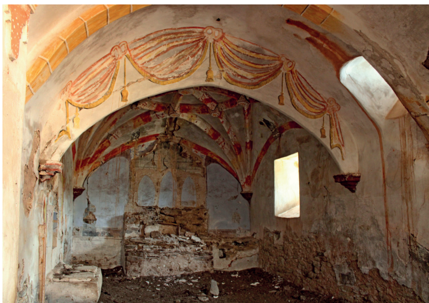
Lám. 9. Interior del templo de Santiago. Ribalmaguillo (2021).
